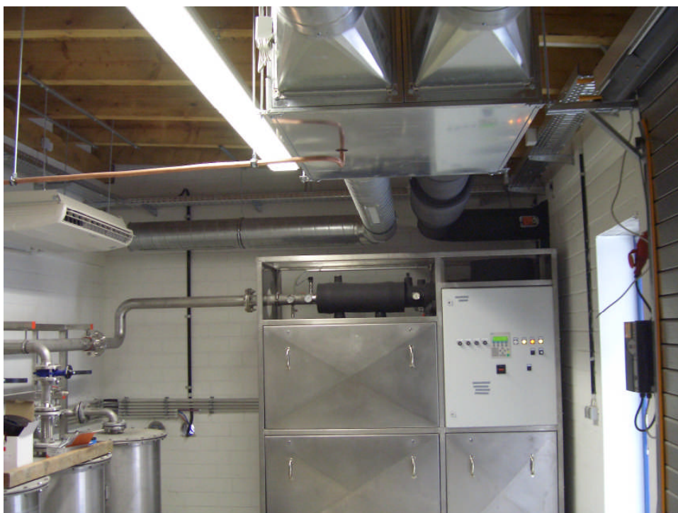
Lüftungskanal mit Filter und einer Inneneinheit der Klima-
