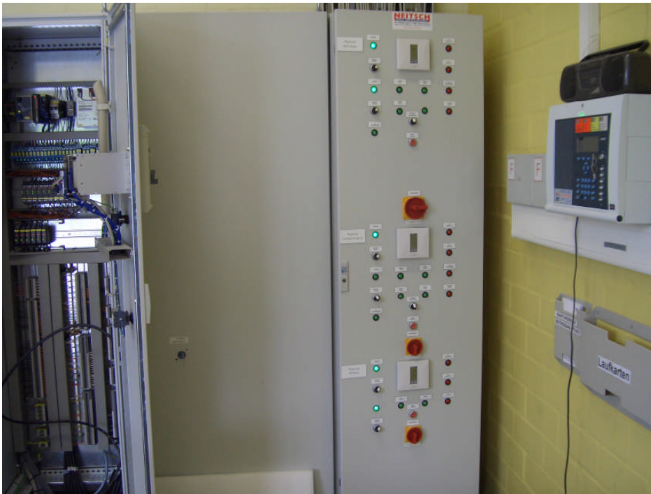
Die Steuerungszentrale, der Schaltschrank, Eigenbau nach (EX) Vorschrift.
